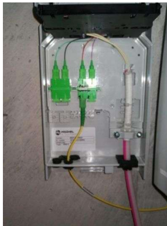
Glasfaser eingeblasen und gespleißt, LWL Patchkabel zu Router angeschlossen
